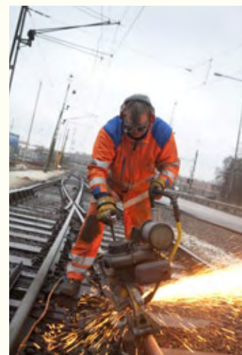
Svetsarbete i Göteborg.
